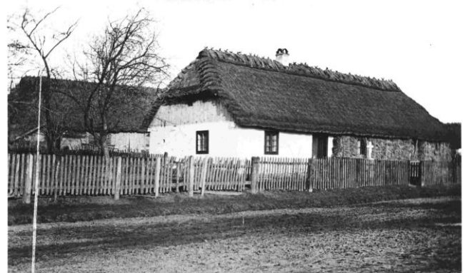
Typisches Siedlerhaus in Wiesenberg Kreis Zólkiew/Galizien (Nr. 4, Ansiedler Kraus) später erweitert, Zustand 1914 mit Wärmeisolierung für den Winter ("Sachaty")
