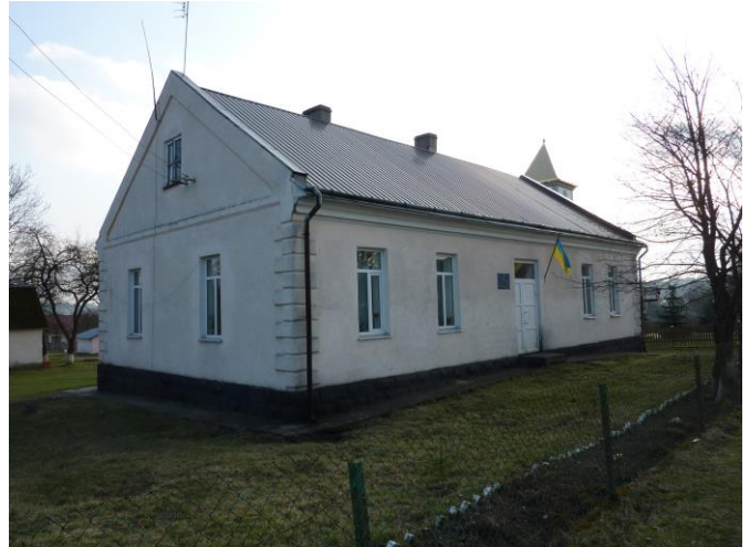
noch immer ein Schulhaus
