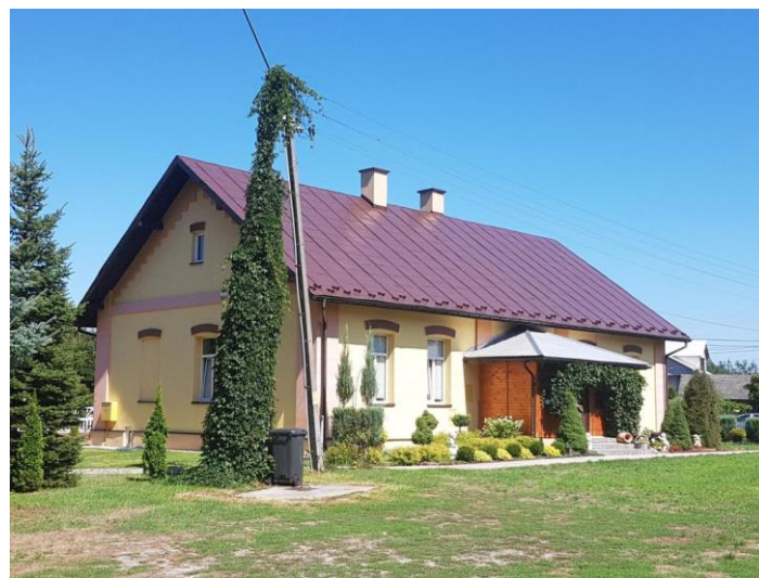
Das ehemalige deutsche Schulgebäude ist jetzt katholisches Pfarrhaus.
