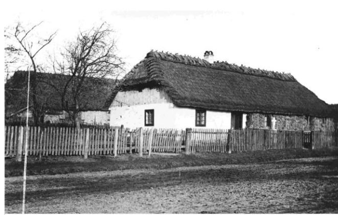
Typisches Siedlerhaus in Wiesenberg Kreis Zólkiew/Galizien (Nr. 4, Ansiedler Kraus) später erweitert, Zustand 1914 mit Wärmeisolierung für den Winter ("Sachaty")
